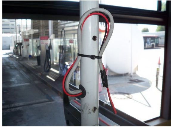
Imagen 15. Agujero de salida cables validadora.
